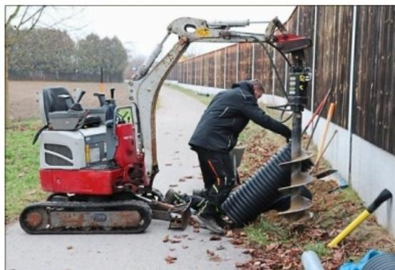
Zunächst bohrten die Arbeiter die Löcher für die Bodenröhren.
