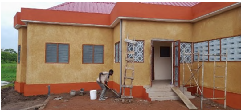
Ein Teil der Krankenstation
