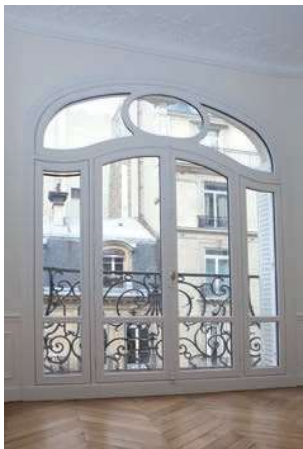
Porte fenêtre Tradilou avec imposte anse de panier et traverse chapeau de gendarme
