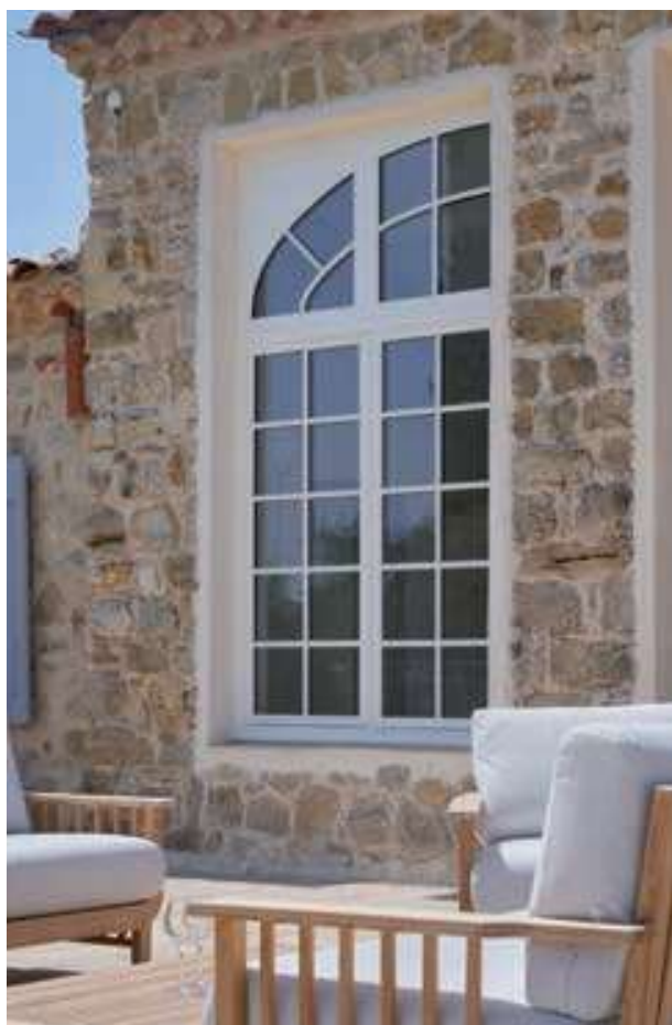
Imposte avec dormant coin mouchoir
