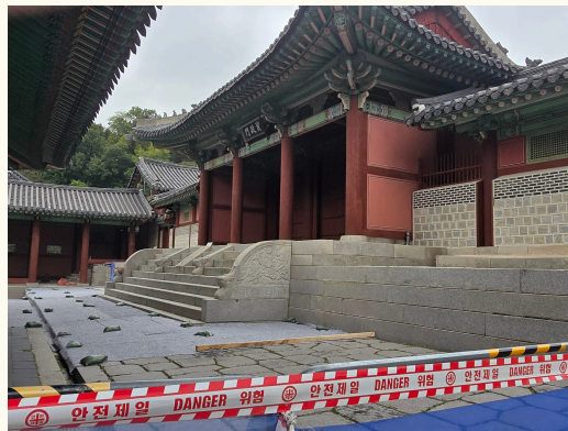
La porte Jajeongmun et le Jajeongjeon en cours de restauration lors de ma visite.
