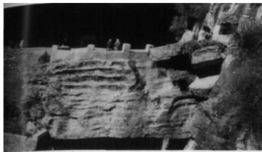
Die Bhima-Brücke im indischen Himalaya kurz vor der Grenze zum Tibet: Über eine 25 m tiefe und 10 m breite Schlucht des Flusses Alakananda ist ein grob bearbeiteter Steinquader gelegt, an der einzigen Stelle, wo sich zwei Felsvorsprünge gegenüberliegen. Der Stein ist rund 14 m lang, 8 m hoch und 4 m breit, geschätztes Gewicht: 900 t (1: Blick von Süden; 2: Blick von Norden). Die Überlieferung sagt, dieser Stein sei vor fünftausend Jahren von Arjunas Bruder Bhima mit geistigen Kräften (S. 20) über die Schlucht gelegt worden, während ihres Lichtkörpermarsches. (S. 281 f.)
