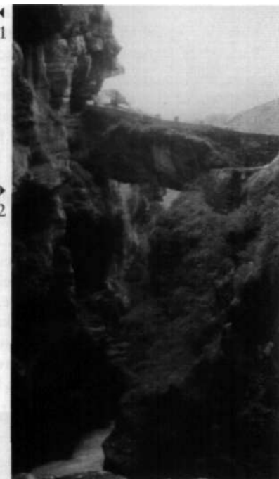
Die Bhima-Brücke im indischen Himalaya kurz vor der Grenze zum Tibet: Über eine 25 m tiefe und 10 m breite Schlucht des Flusses Alakananda ist ein grob bearbeiteter Steinquader gelegt, an der einzigen Stelle, wo sich zwei Felsvorsprünge gegenüberliegen. Der Stein ist rund 14 m lang, 8 m hoch und 4 m breit, geschätztes Gewicht: 900 t (1: Blick von Süden; 2: Blick von Norden). Die Überlieferung sagt, dieser Stein sei vor fünftausend Jahren von Arjunas Bruder Bhima mit geistigen Kräften (S. 20) über die Schlucht gelegt worden, während ihres Lichtkörpermarsches. (S. 281 f.)
