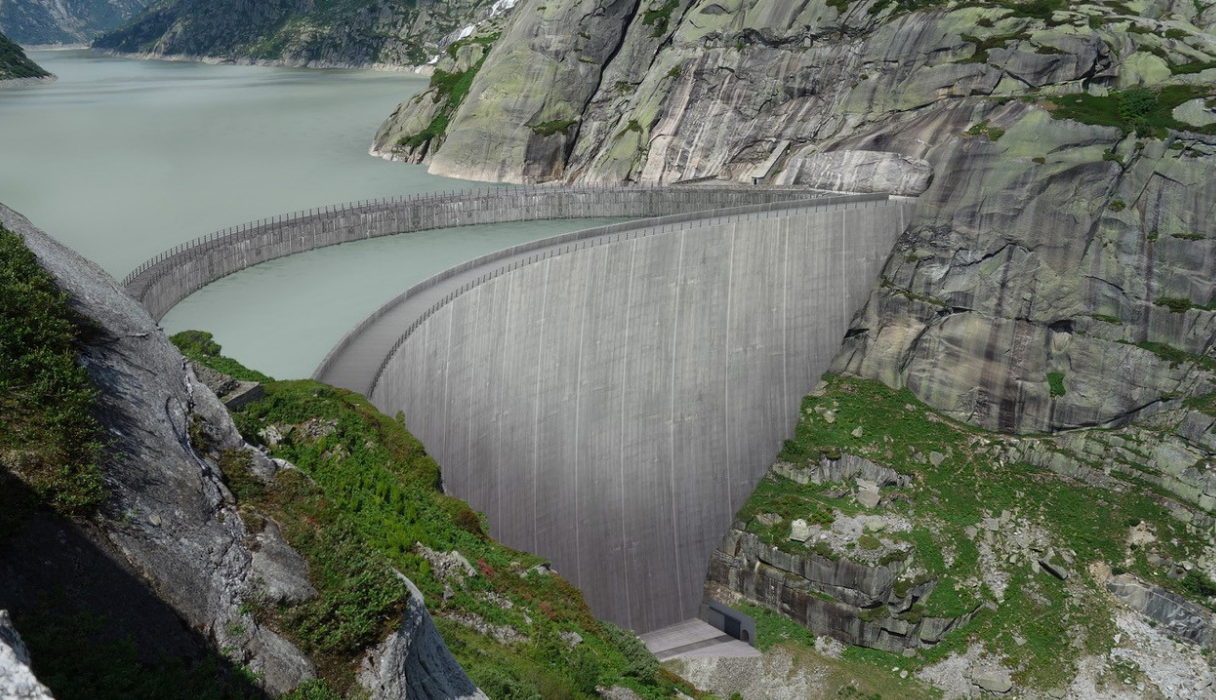
Vollstau Standpunkt Hospiz (Süd-West)
