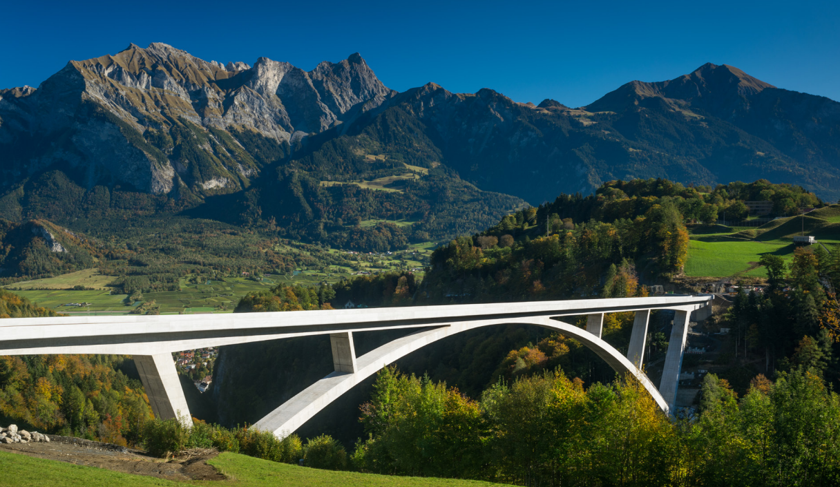
Taminabrücke, Pfäfers Leonhardt, Andrä und Partner / © Bastian Kratzke
