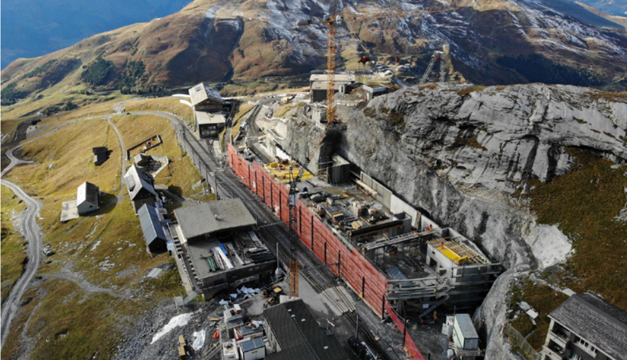
Baustelle Bahnstation Eigergletscher
