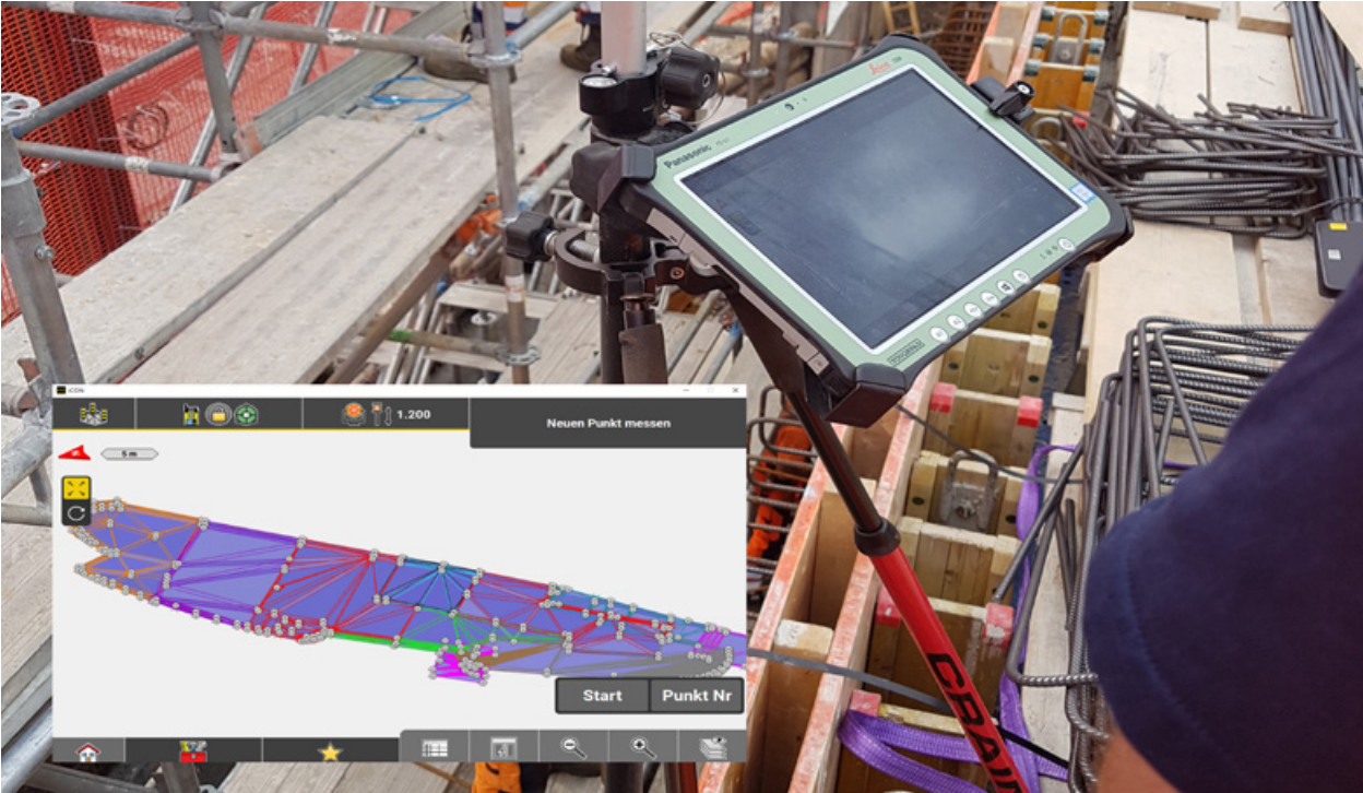
3D-Modell Bodenplatte auf Leica Robotic-Totalstation zur direkten Absteckung
