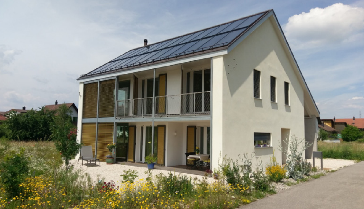
Aussenansicht EFH Hengelweg, Würenlingen
