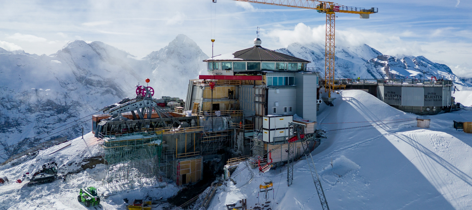
Drohnenaufnahme Piz Gloria Bauphase Spur 3.2 im April 2025 (Foto: Dr. Martin Deuring)
