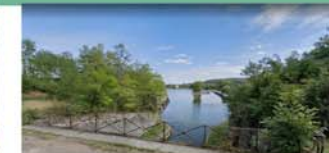
Foug (tunnel du canal de la Marne au Rhin)
