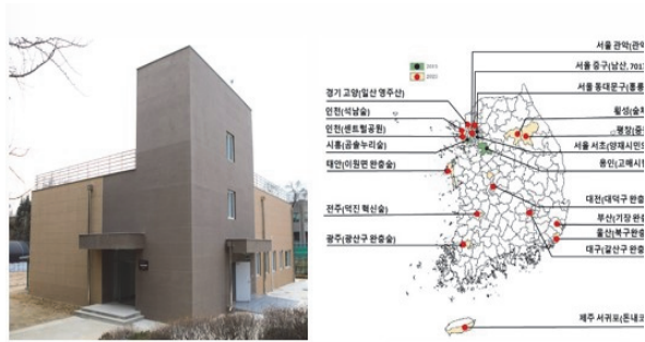
미세먼지 연구동 및 측정넷 구축 현황
