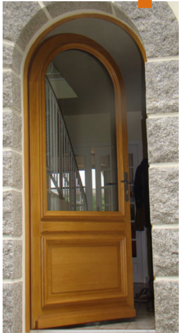
Porte cintrée avec panneau plate bande et moulure grand cadre
