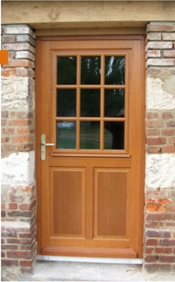
Ouverture extérieure avec meneau mortaise et petit bois collés
