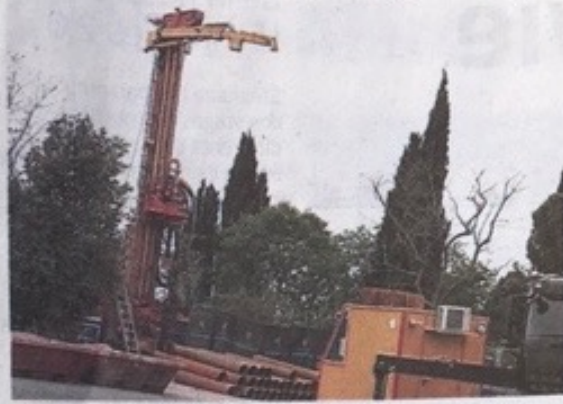
Au programme, découverte du chantier du forage en cours.
