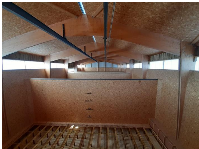
Cloisons des cellules de stockage
