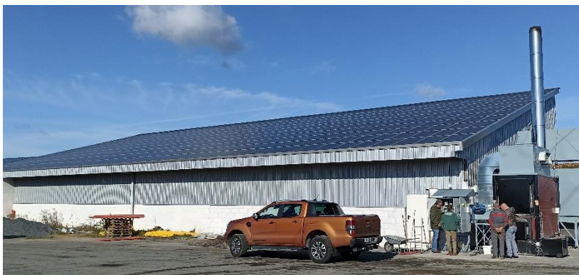
Hangar monopente équipé de panneaux photovoltaïques intégrés à la couverture
