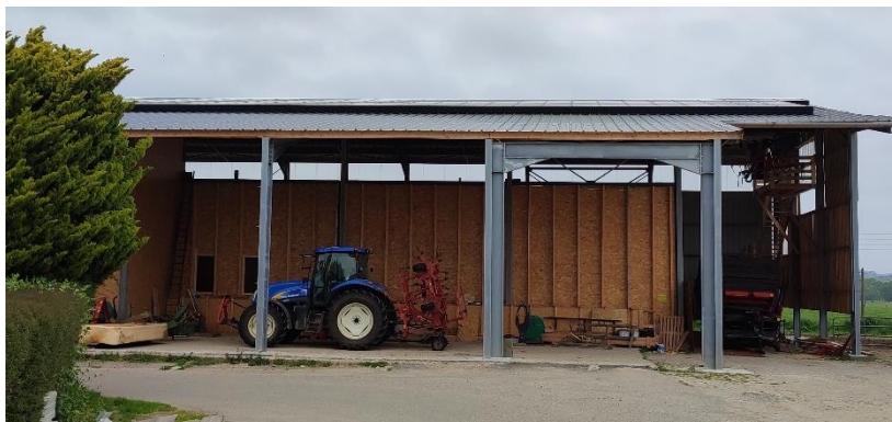
Séchoir de foin en grange équipé de panneaux photovoltaïques avec récupération de chaleur
