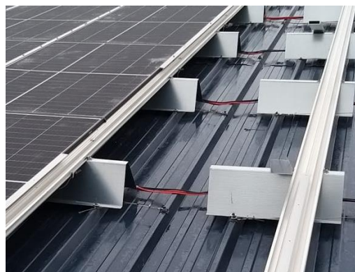
Pose des panneaux sur rail et cale métallique
