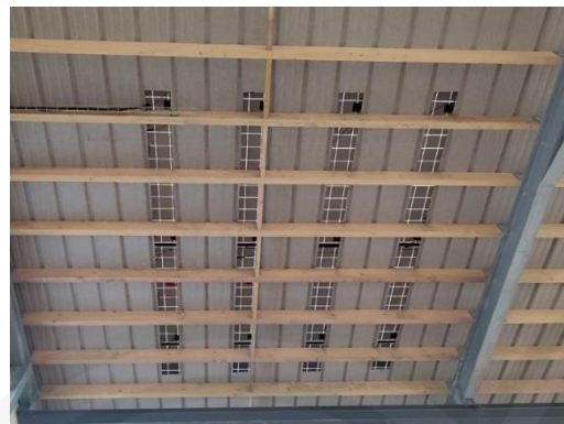
Vue de la travée du collecteur d'air avant construction du collecteur d'air chaud
