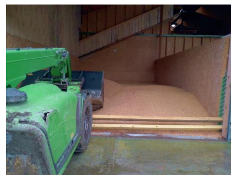
Dispositif de maintien des céréales de front pour un séchage homogène
