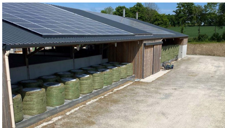
Séchoir de foin en bottes rondes avec récupération d'air chaud sous panneaux photovoltaïques
