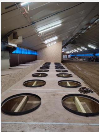
Séchoir simple flux 2 x 18 bottes rondes entièrement réalisé en auto construction dans un ancien poulailler (source photo : SEGRAFO)
