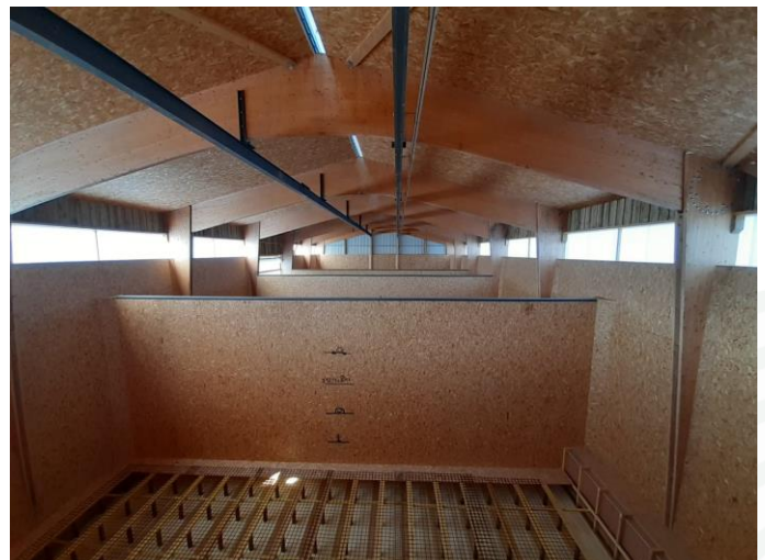
Cloisons des cellules de stockage
