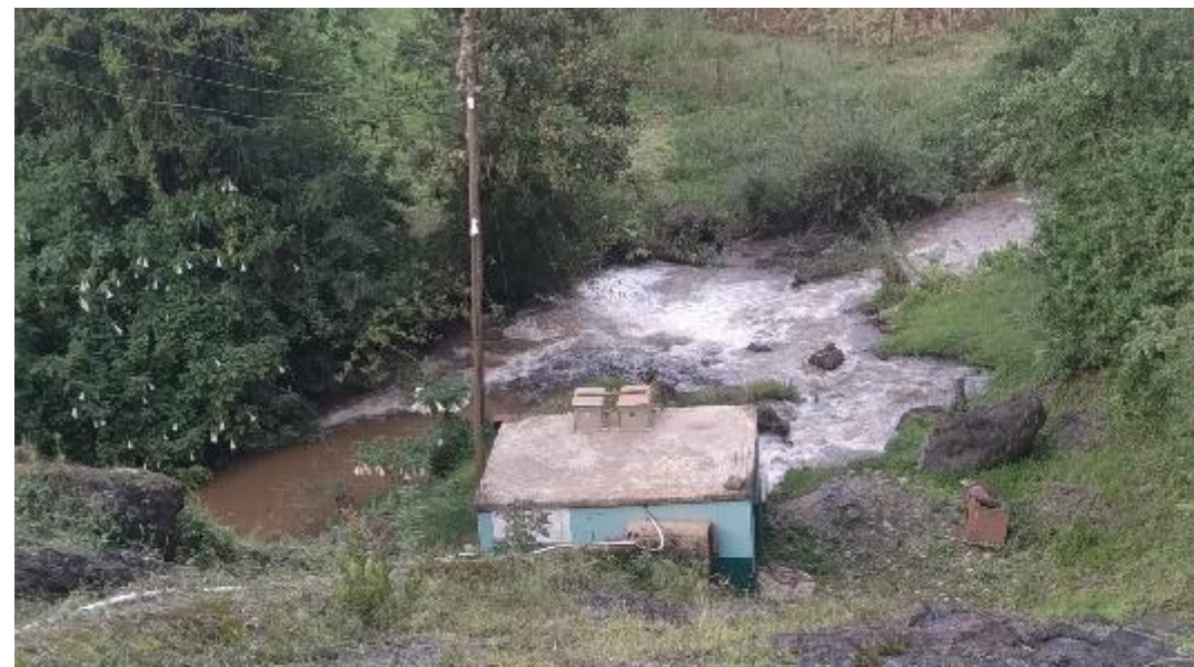
Magiro hydro mini grid, Murang'a County
