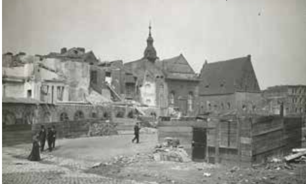
Bourání domů v místech dnešní Pařížské ulice při asanaci Josefova
