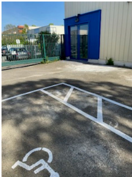
Seconde porte avec rampe d'accès pour PMR
