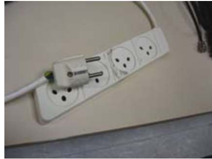
איור 5-1: תקע התואם לתקן אירופי אך אסור לשימוש בישראל בגלל אי התאמה לתקנים המקומיים. מיקום החיבור להארקה על צידו של גוף התקע יותיר את התקע ללא חיבור להארקה בבית תקע רגיל בישראל בנוסף: גם חיבור הפתיל אל התקע איננו תקין
