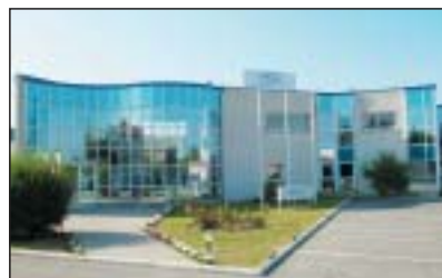
Завод PALL в г. Терне (69)
