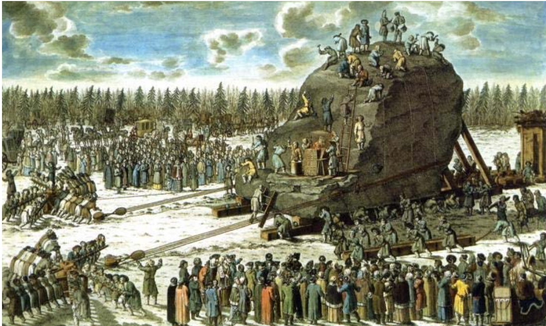
Перемещение огромной гранитной глыбы для пьедестала «Медного всадника». Гравюра по рисунку Е. П. Давыдова. 1782. Engraving after a drawing by E. P. Davydov, 1782
