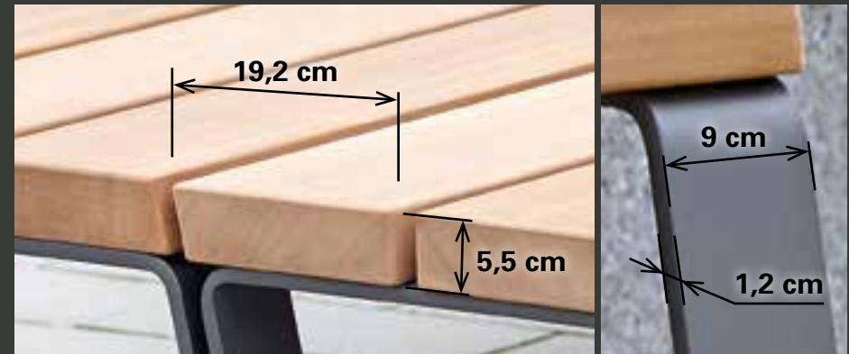
Die massive Holzbelattung ist im Querschnitt 19,2 x 5,5 cm ausgeführt.
