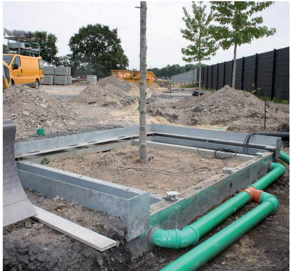
Abb. 2b: Bau der Baumrigole | Foto: Grüning, FH Münster
