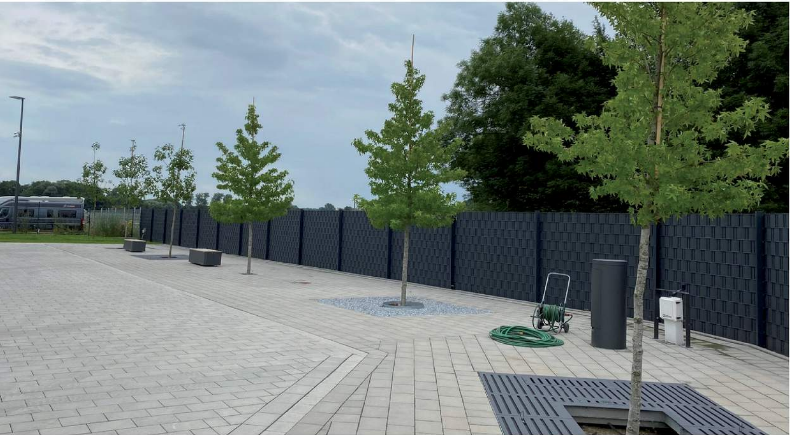
Abb. 3: Baumrigolen nach dem Einbau | Foto: Grüning, FH Münster
