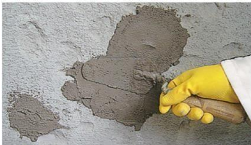
CORREÇÃO E NIVELAMENTO COM ARGAMASSA AC3
