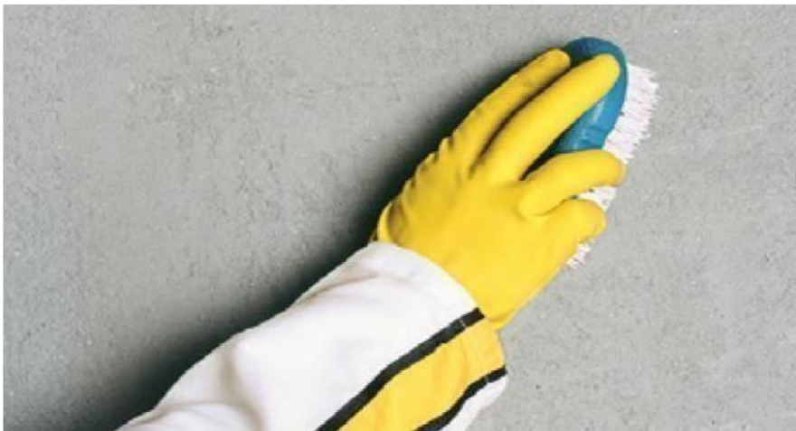
REMOÇÃO DAS PARTICULAS SOLTAS APÓS APLICAÇÃO DO REBOCO
