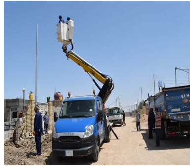
باشرت بأعمال المشروع لتطوير شبكة الضغط الواطي في المنطقة وبإسناد قسم الكهرباء.
