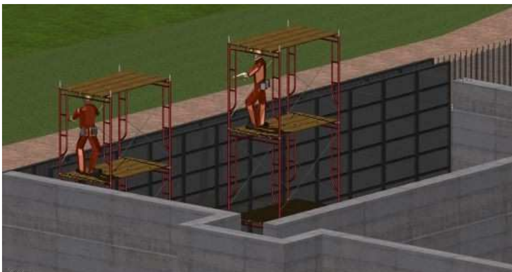
Figura 7. Realizzazione della carpenteria per le successive fasi di getto
