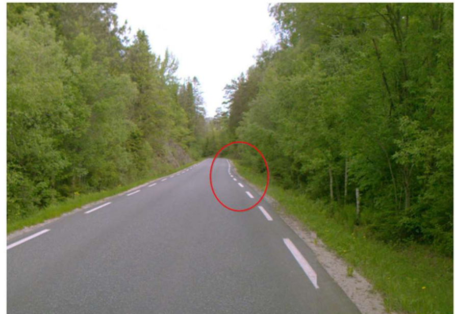
Generell – Utvide vegen der det er unaturlige innsnevringar.
