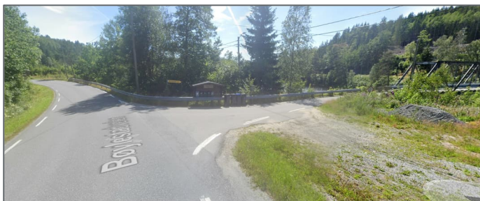
Figur 3-20: Krysset fv. 3718 Bøylestadveien x Bøylestad bru. Uregulert T-kryss. (Bilde: Google Maps Street View, juli 2025)
