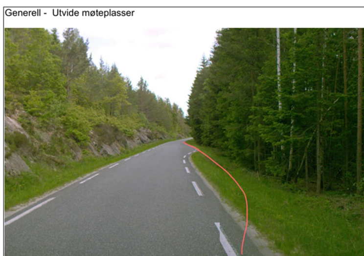
Figur 4-11: Eksempel på utvidelse av møteplass. Hentet fra Agder fylkeskommune sitt notat.
