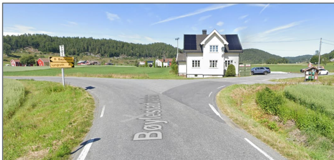
Figur 3-19: Krysset fv. 3718 Bøylestadveien x fv. 3722 Lyngrothveien. Uregulert Y-kryss. Utflytende kryss med 60 km/t inn i krysset. (Bilde: Google Maps Street View, juli 2025)
