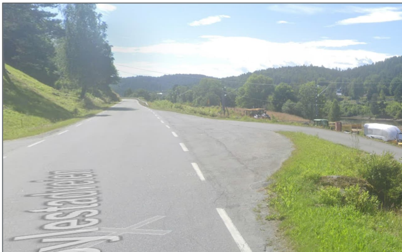
Figur 3-14: Eksempel på avkjørsel som er kombinert med møteplass. (Google Maps Street View, 2025)
