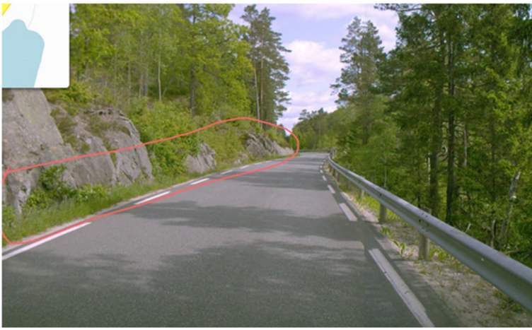
Figur 4-4: Hentet fra Agder fylkeskommune sitt notat. Agder fylkeskommune har foreslått mer omfattende utretting av vegbanen til en lengre kurveradius med breddeutvidelse. Sammenfallende med strekning 3 i figuren over, hvor også Norconsult vurderer at vegen bør breddeutvides.
