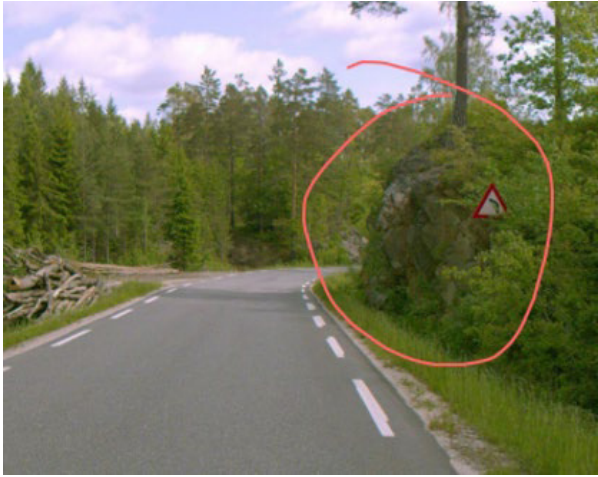
Fig. 2 Eksempel på siktsprenging
