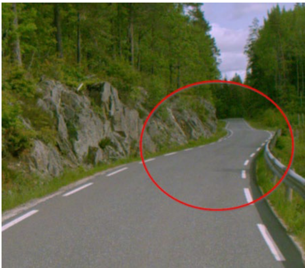
Fig. 2 Utretting av kort kurve, møteplass
