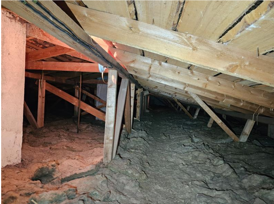
Foto 37. Puidust katusekonstruktsioonide seisukord on hea, paikvaatlusel läbijooksusid katusekattest ei avastatud.
