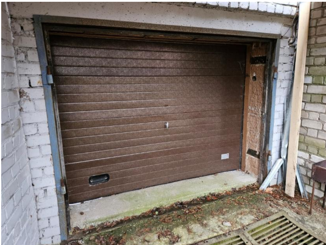
Foto 12. Hoone loodeküljes asuva garaaži uks on asendatud.
