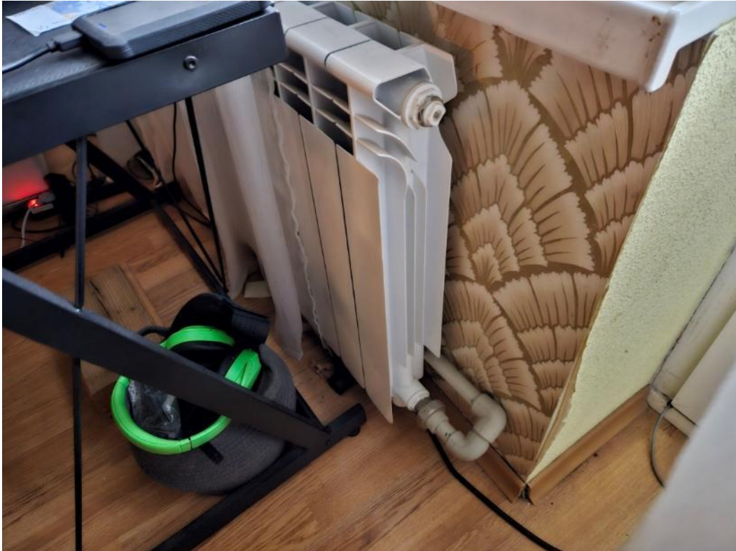
Foto 47. Korteris on näha vahetatud radiaator ning uuendatud küttevõetorustik.
