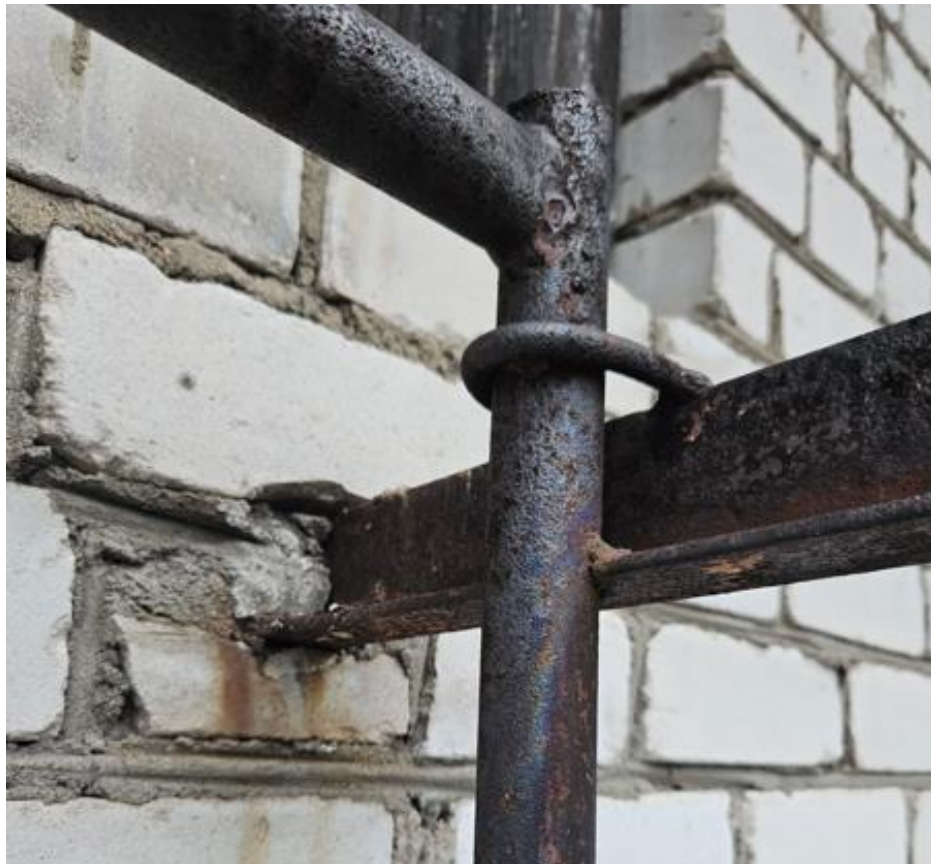
Foto 39. Pööninguredeli kinnituste keevisühendused veel peavad, kuid on ainsad kinnitused redeli ülemises otsas.
