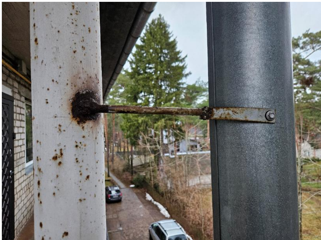
Foto 22. Sadeveetorustiku kanduri kinnitus hoone terasposti külge.
