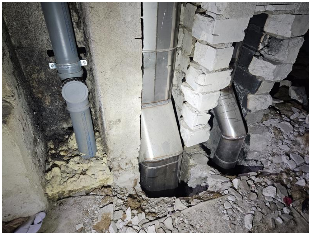
Foto 34. Korstnate püstikutesse on paigaldatud uus torustik, sh. happekindel roostevaba torustik.
