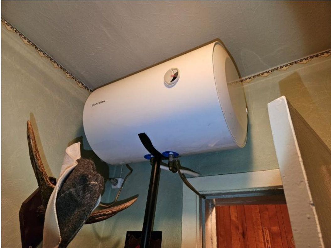
Foto 51. Elektriboiler sooja tarbevee valmistamiseks korteris.
