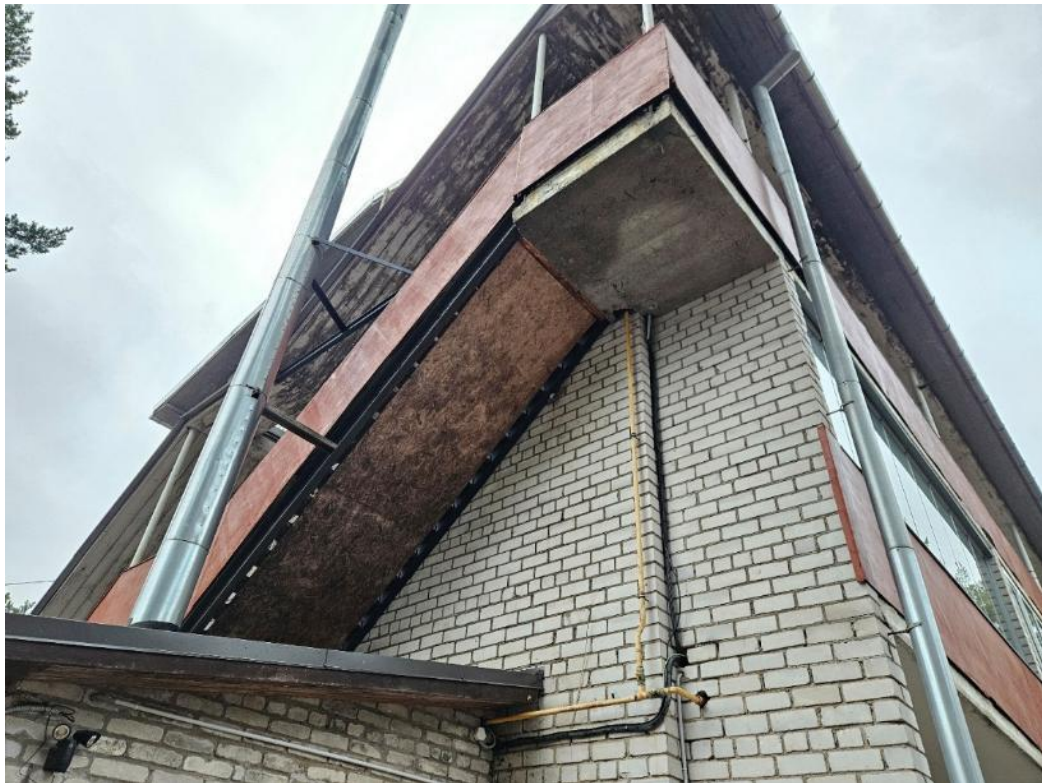
Foto 19. Kolmandale korrusele viiv välitrepp hoone kaguküljel on soovitatav lammutada enne renoveerimistööd.
