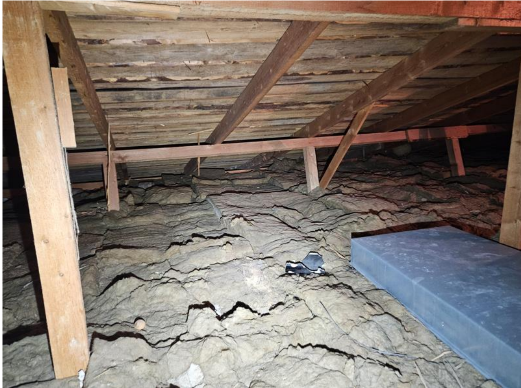
Foto 35. Klaasvillast soojustusmatid hoone pööningul.
