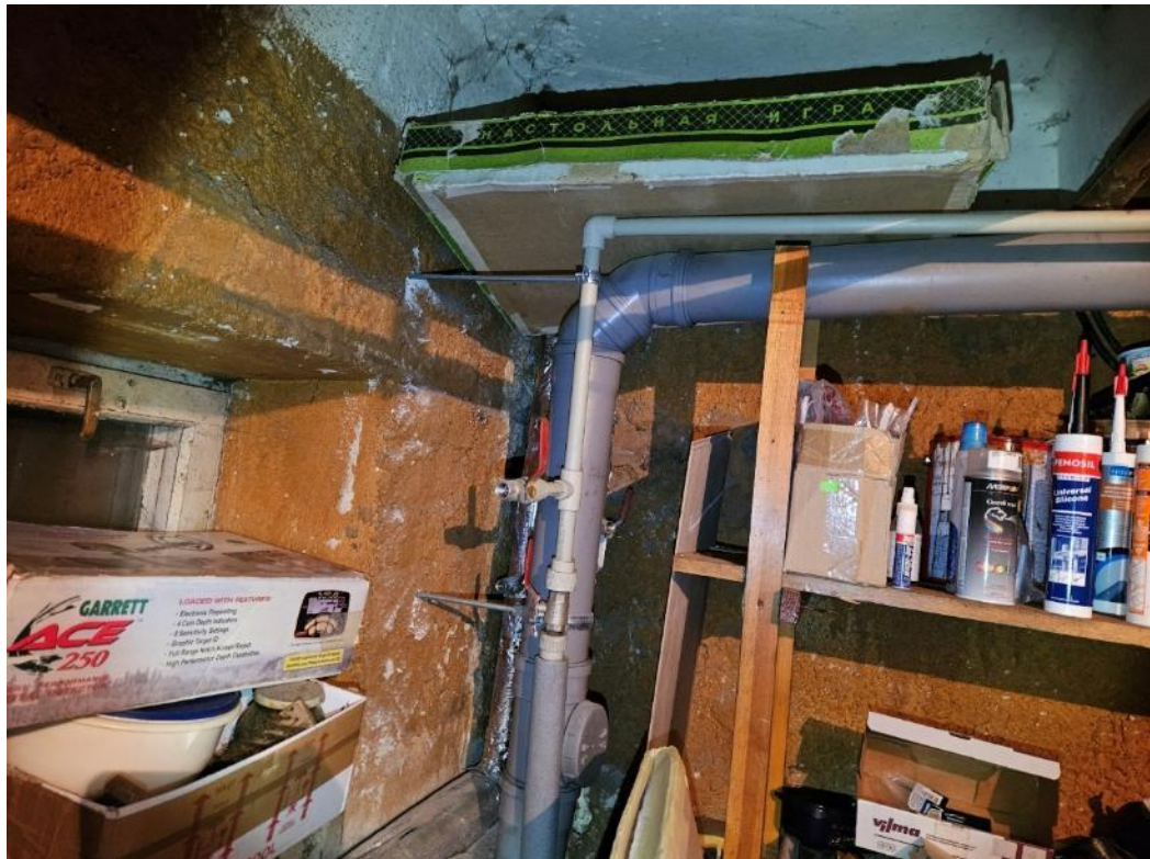
Foto 41. Vaadeldava korteri keldriosa, kus on näha torustiku osalist asendamist, samuti puuduseid kinnitite osas.
