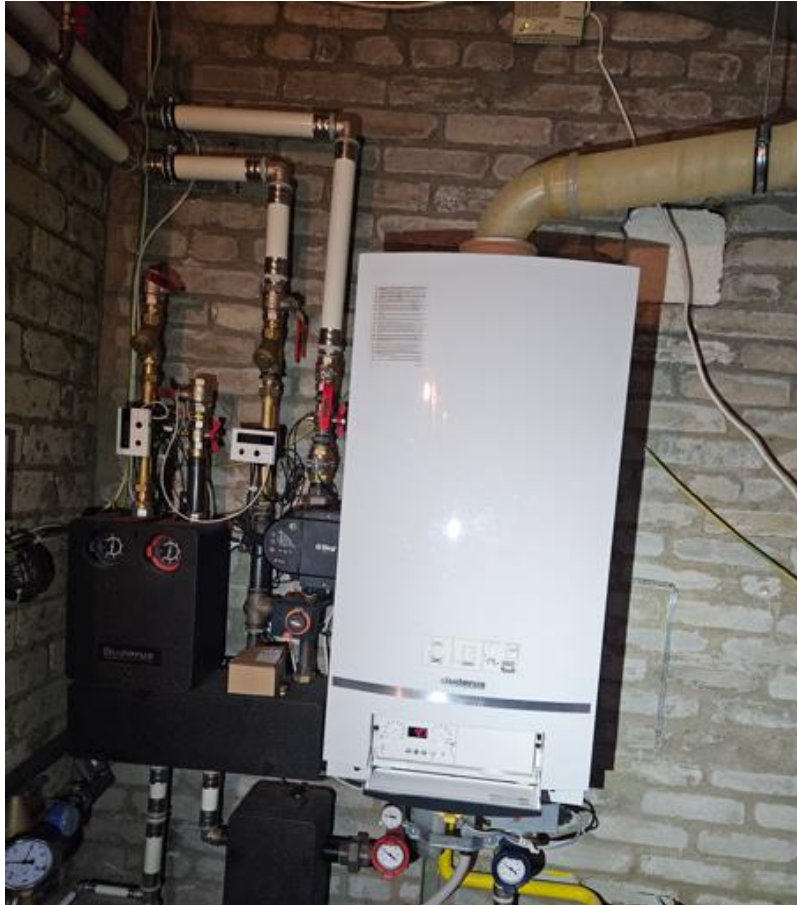
Foto 25. Katlaruum, mille sisseseade on ehitusjärgsel perioodil uuendatud. Paigaldatud on uus torustik, segusõlm ja katel.
