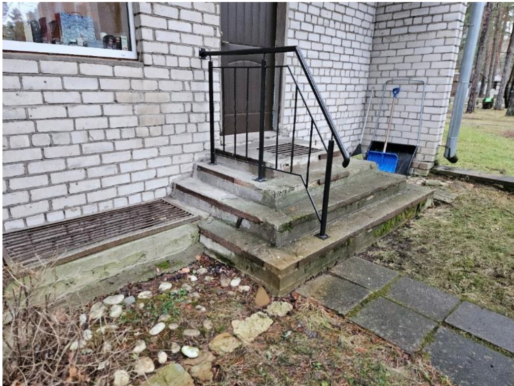
Foto 7. Elamusse pääsuks kasutatavad trepid on osaliselt ehitusaegsed.
