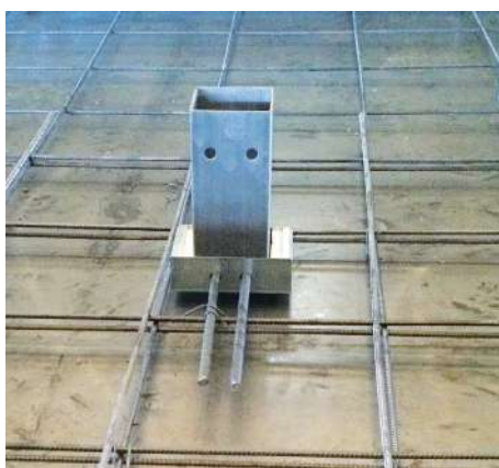
Fondo cassero Formwork
