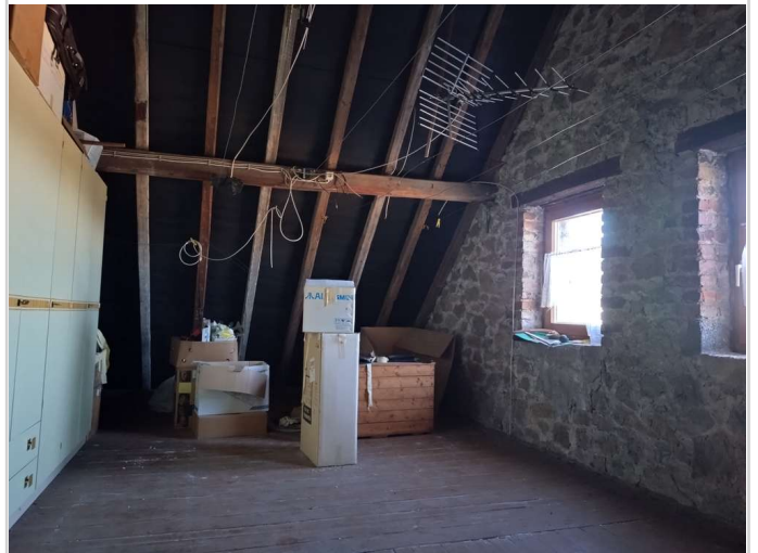
Ausbaureserve DG Haupthaus (2)
