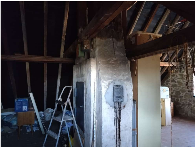
Ausbaureserve DG Haupthaus (1)
