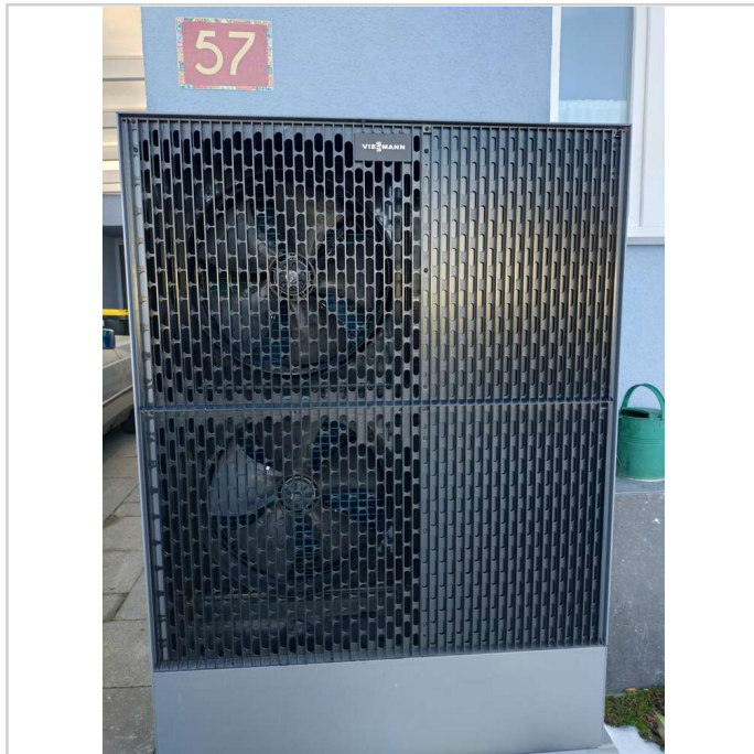
Wärmepumpe außen
