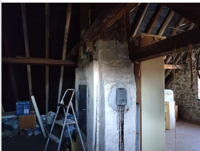
Ausbaureserve DG Haupthaus (1)
