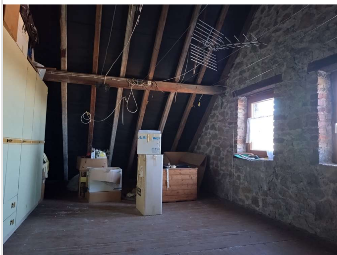
Ausbaureserve DG Haupthaus (2)
