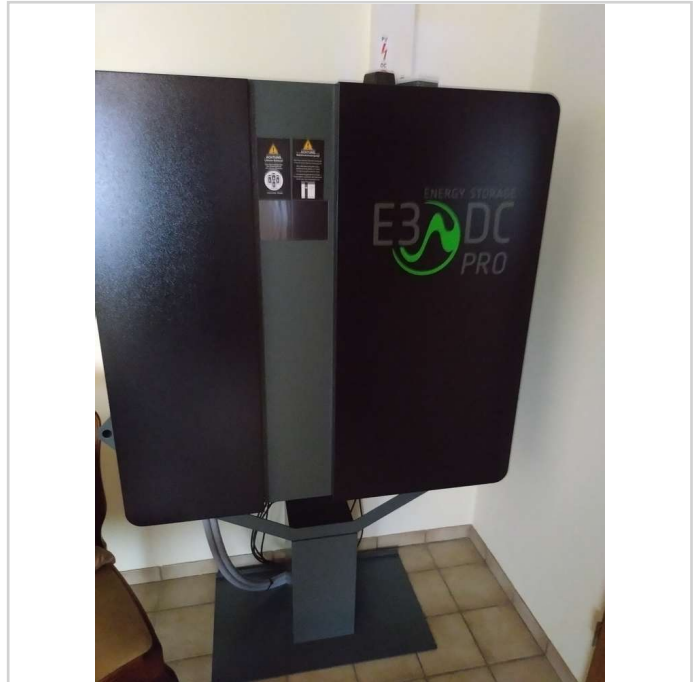
Batteriespeicher 19 kW
