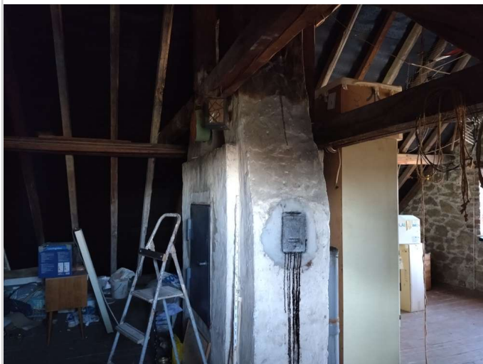
Ausbaureserve DG Haupthaus (1)
