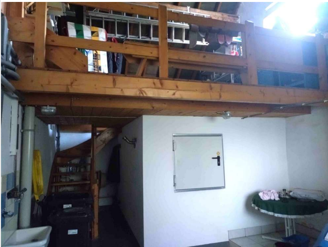
Heizraum und Empore
