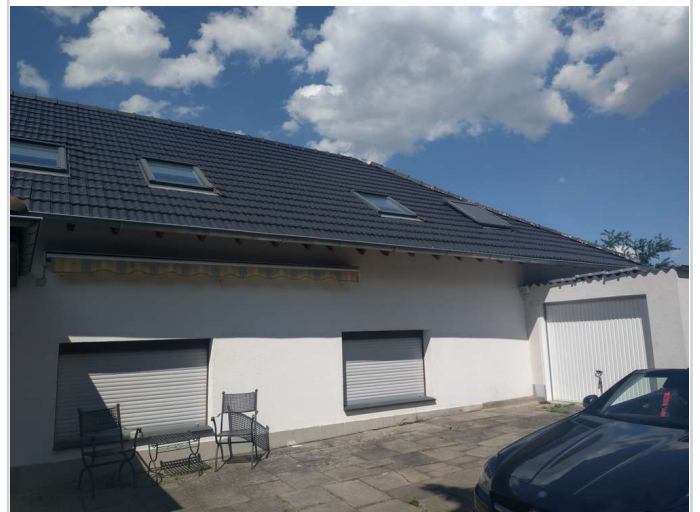
Anbau mit Garage
