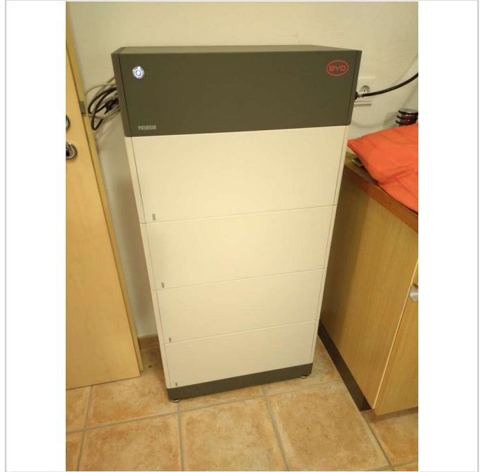
Batteriespeicher 10 kWh
