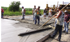
Worker, Laborer Trabajador, Obrero
