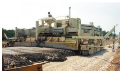
Paver Pavimentadora, Carpeteadora
