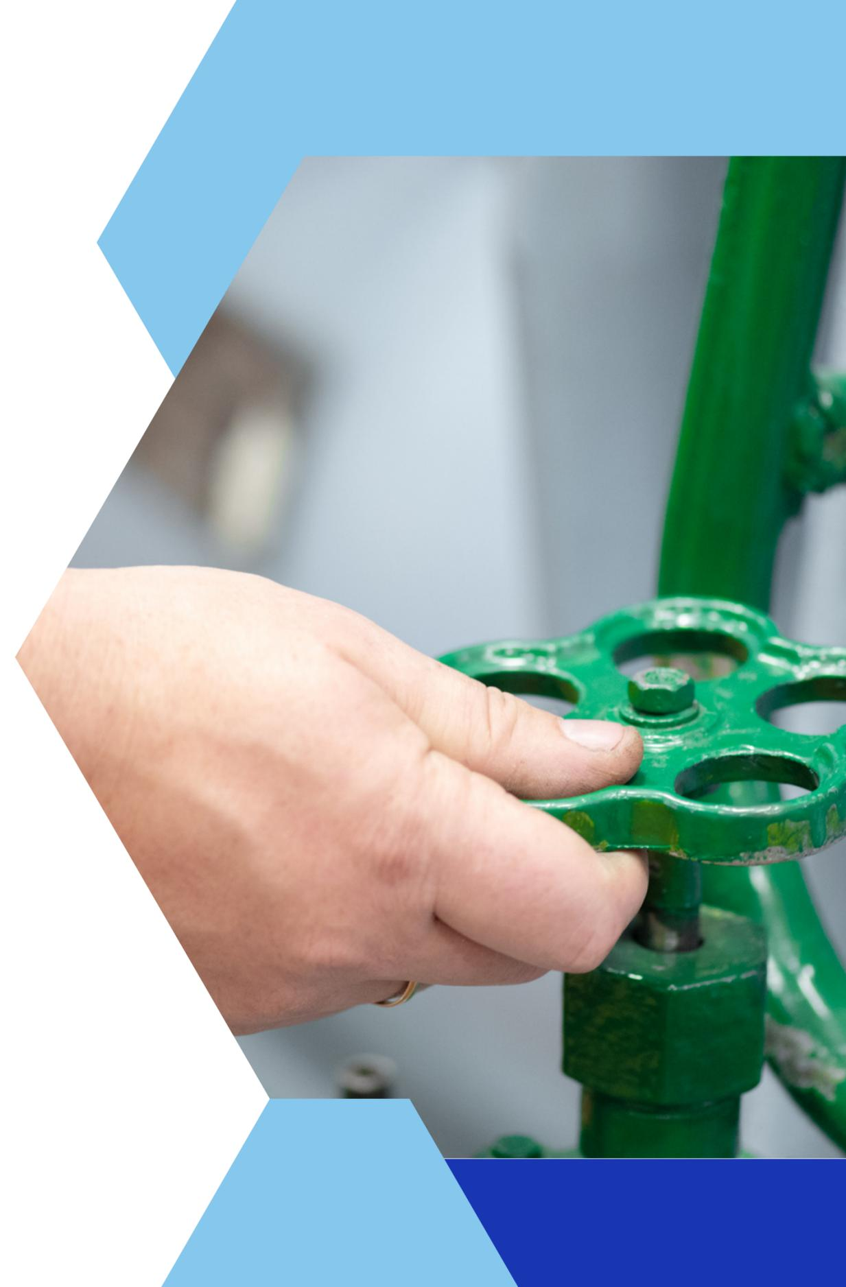
**Les vannes d'isolement** permettent d'isoler du réseau certains tronçons qu'on veut inspecter, réparer ou entretenir: pour les gros diamètre (350 mm et plus), on utilise des **robinets à papillon**, pour les petits diamètres, **des robinets-vannes** .
