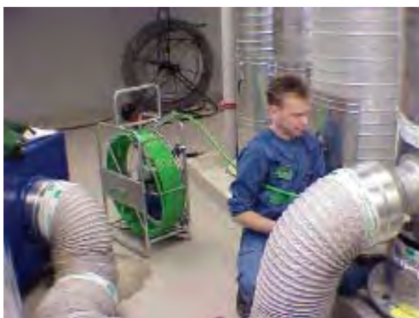
Rengjøring med roterende børste med motordrift via en vaier. Et kraftig sugeaggregat samler opp smuss via en fleksibel kanal. Foto: Lifa Air Ltd. Finland
