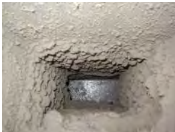
Tilsmusset avtrekkskanal. Foto: Danduct
