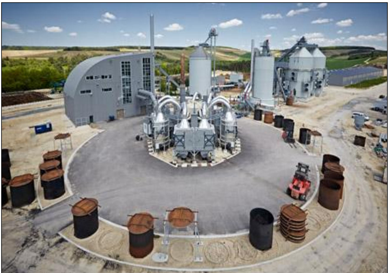
Installation « CARBONEX » 2012 : Préséchage des bois, Carbonisation, Production d'électricité.
