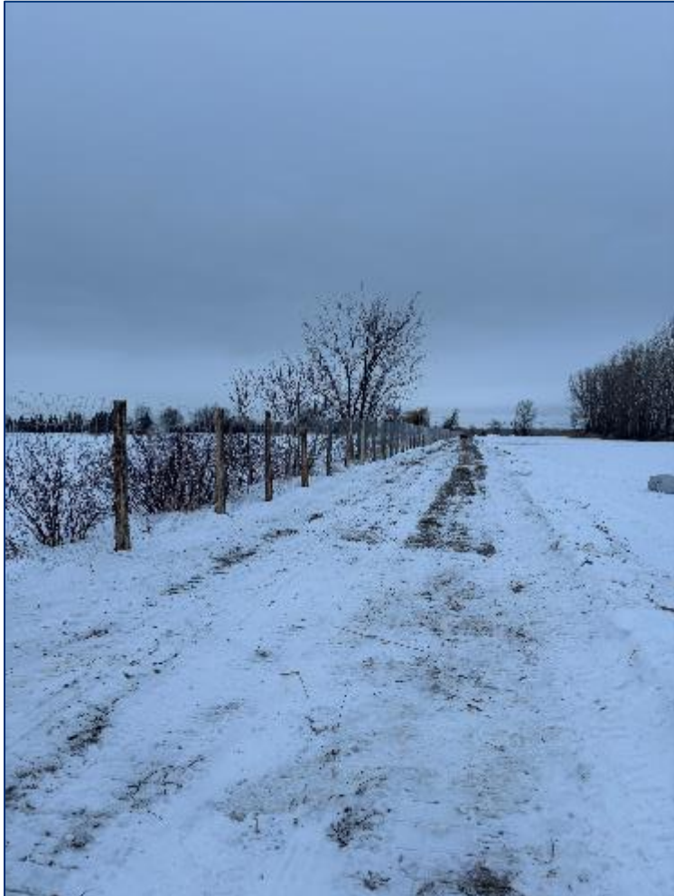
Installation de clôtures
