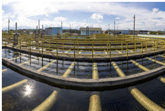
Estação de tratamento de Saneapar, no Paraná, estatal está entre as que buscam investimentos privados em forma de PPP para universalização dos serviços de saneamento. | Foto: Divulgação/Saneapar
